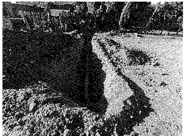
Excavación de terreno y colocación de tubería de 6" correspondientes a las descargas domiciliarias.
